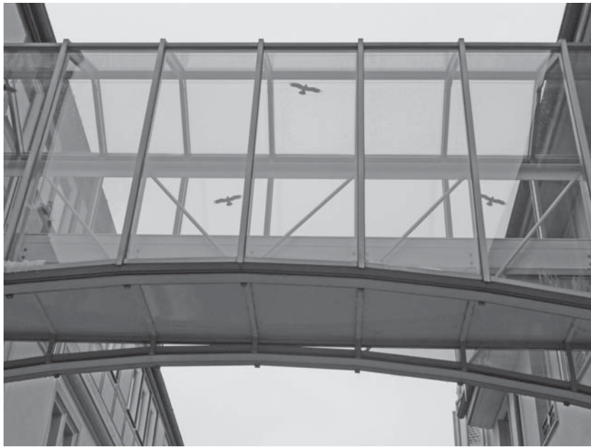
Abb. 5: Verglaste Fußgängerbrücke mit Raubvogelattrappen in der Innenstadt von Freiburg im Breisgau.
